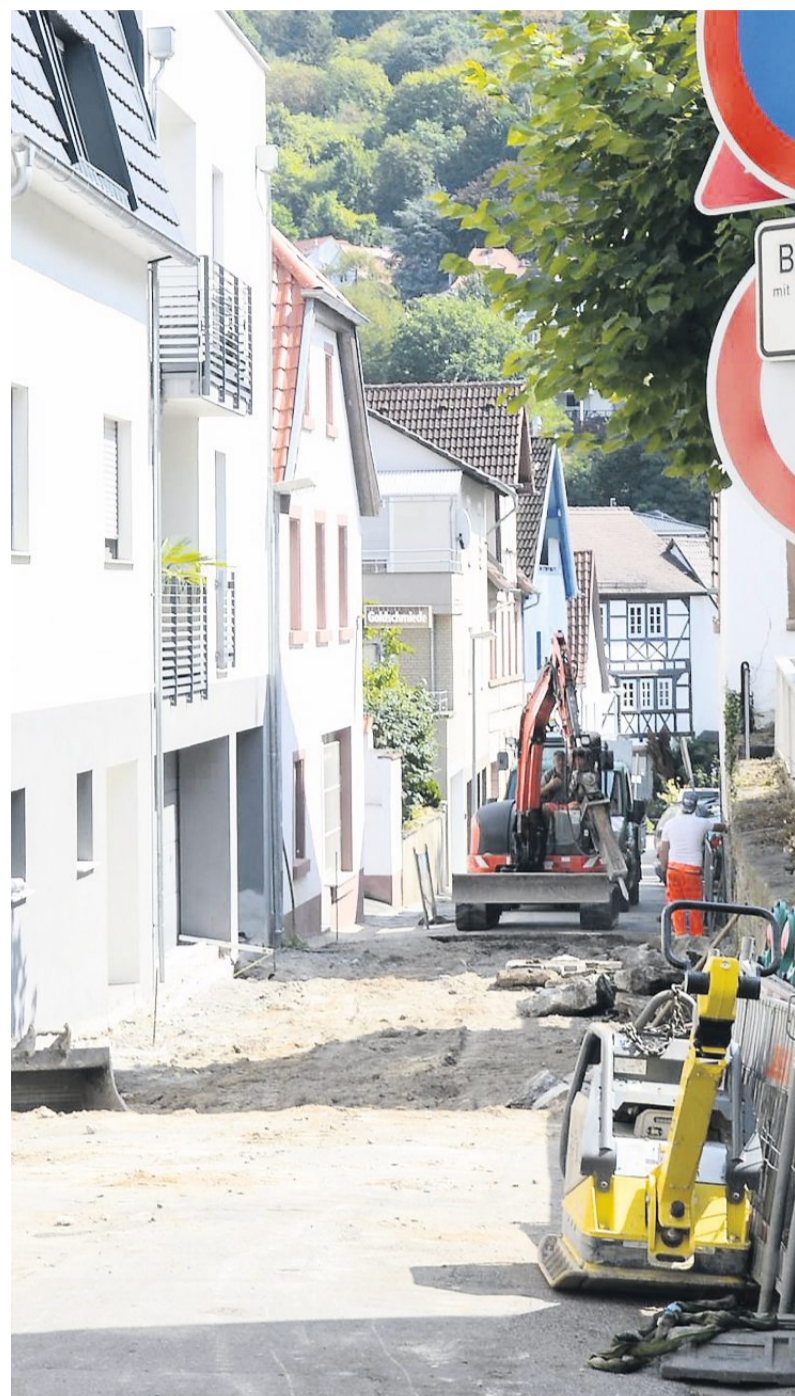
Drei Wochen soll die Erneuerung eines Teilabschnitts der Lindenstraße in Weinheim dauern. BILD: THOMAS RITTELMANN
