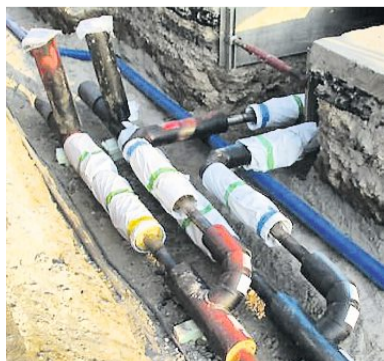
So sieht es aus, wenn das Wärmenetz ausgebaut wird.
