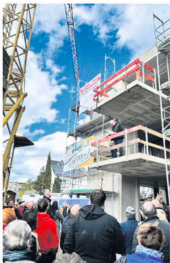
Die Bauträger-Gesellschaft Steinbau GmbH feierte Richtfest für ihr Bauvorhaben in der Brückstraße 2.
